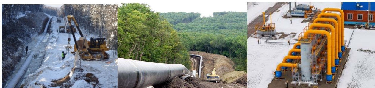
Рис. 1. Общий вид производственных участков
